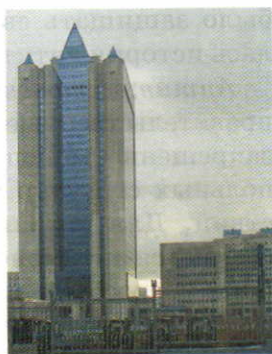
Центральный офис ОАО «Газпром»
