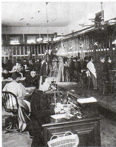
На телефонной станции
