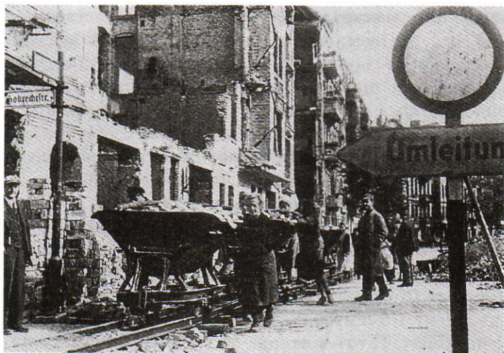
Восстановительные работы в Берлине. 1946 г.
