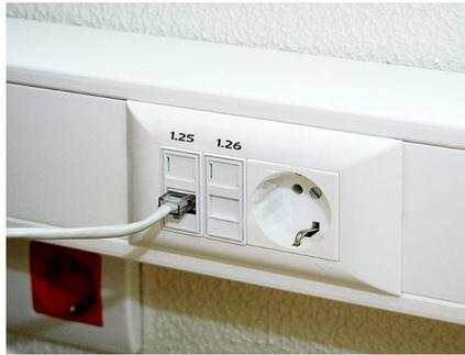
Рис. 3.58 Вариант установки и маркировки розеток
